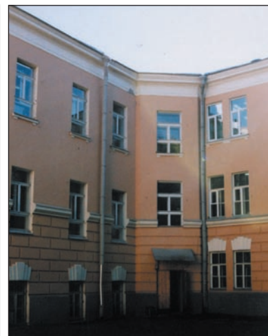
Окна квартиры И. А. Каблукова на 3-м этаже
